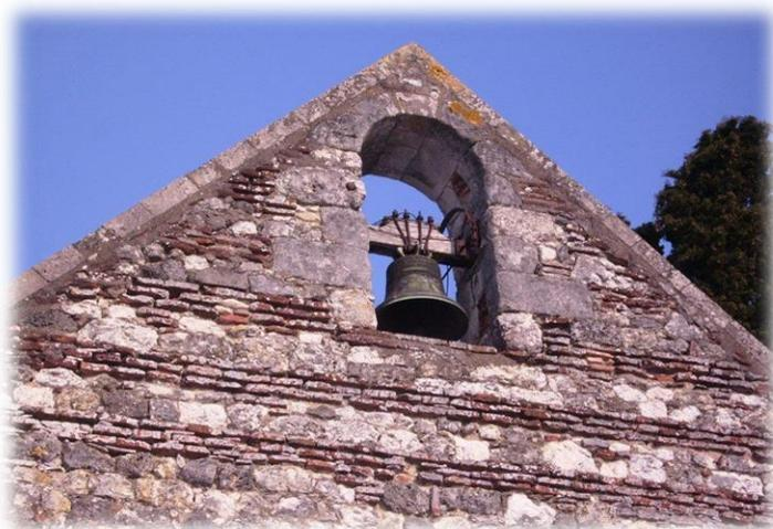
Les murs sont en moellons équarris avec cependant certaines parties en pierres et briques en assises alternées et le soubassement du mur nord du chevet en pierre de taille.
